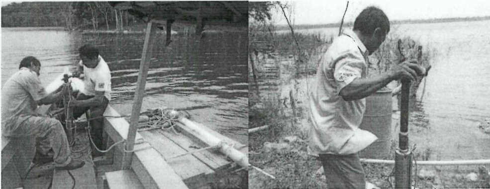
Realizando las respectivas pruebas para la instalación de la bomba sumergible.
