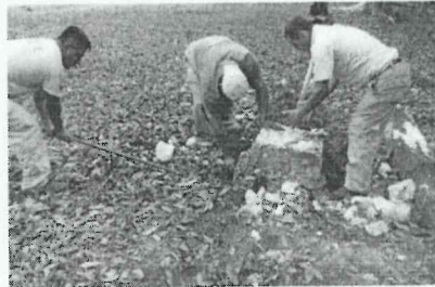
Trabajos para la reparación del sistema de tratamiento de aguas
